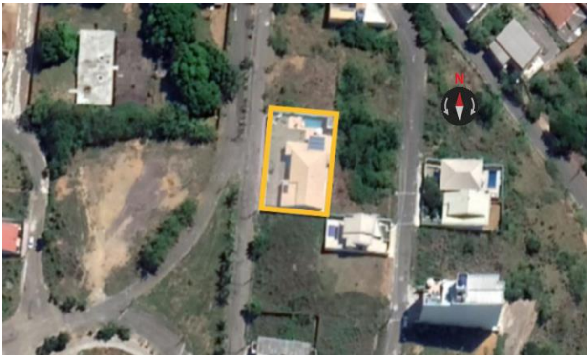
Figura 1 - Vista aérea da residência estudada. Fonte: Modificado do Google Earth.
